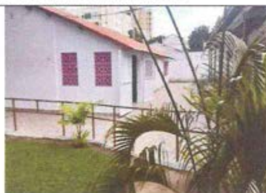
Reforma do Casarão
